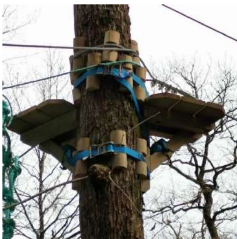
Figure 4 – Plateformes pétales avec cales et sangles
