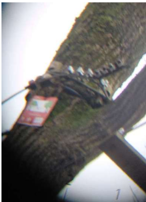
Figure 11 – Vertige – n°185 : cerclage sur charpentièr
